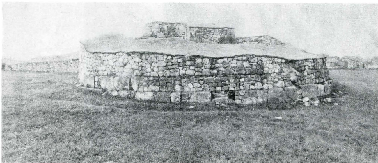
Capidava — latura de NV după restaurare.
