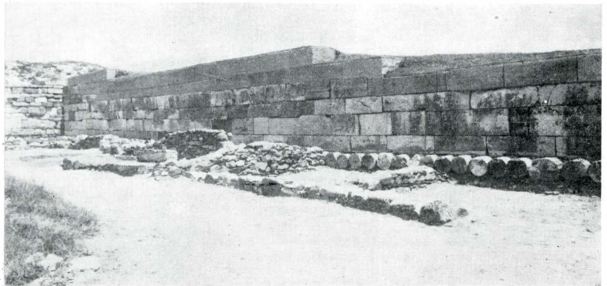
Cetatea Histria — curtină cu partea superioară a paramentului exterior restaurată cu blocuri de simlipiatră.
