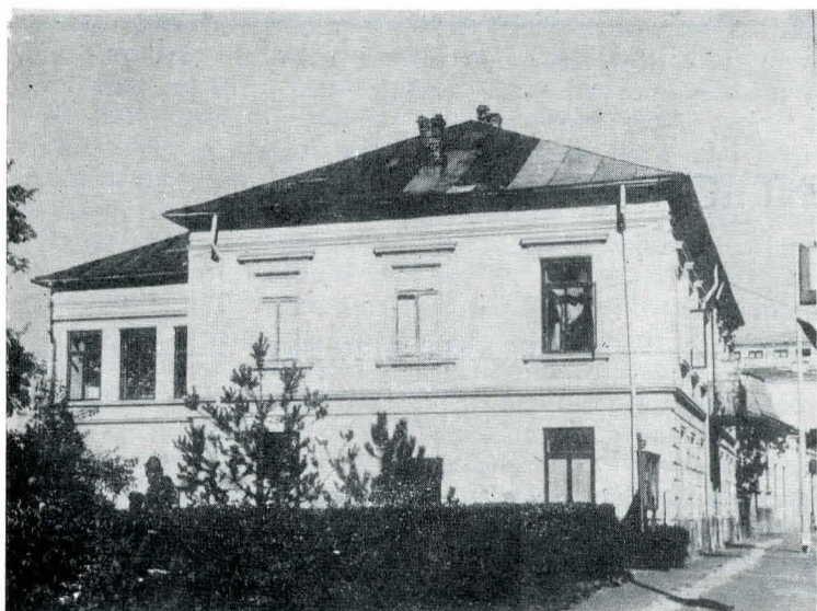
6. Casa Oteteleşeanu în starea actuală.
