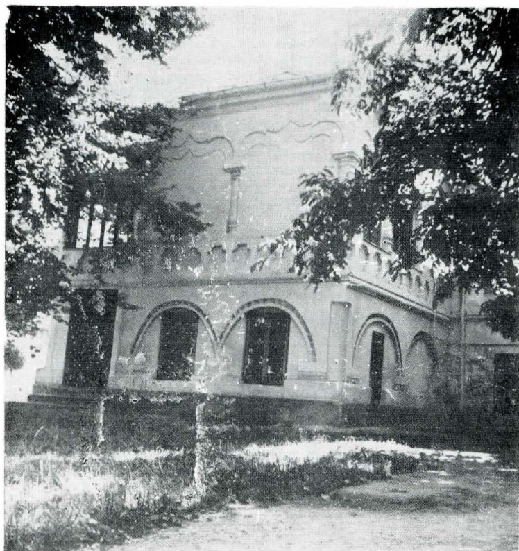
4. Casa Măldărescu, vedere a pridvorului înzidit.
