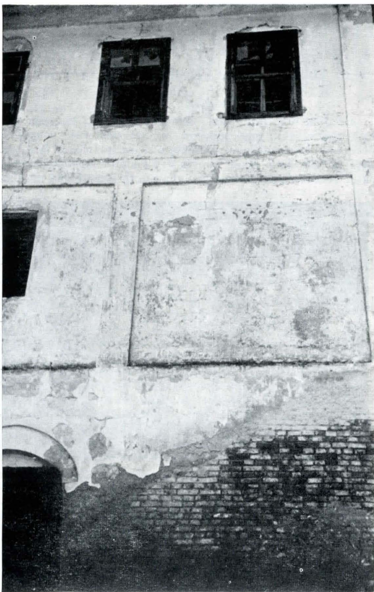
Cula din Brabova. Detaliu de arhitectură de la fațada din est.
