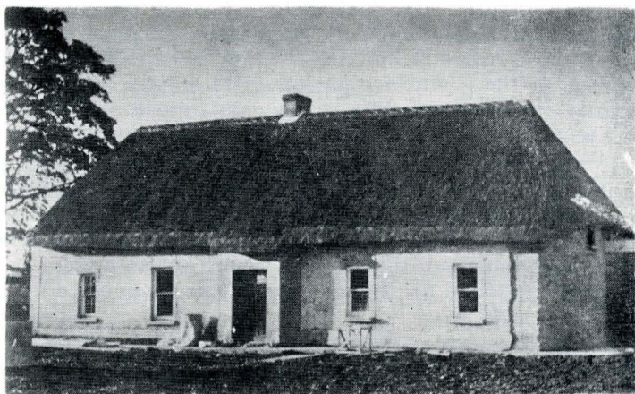
Maison de paysan aisé du VIII e siècle à Callan, comté de Kilkenny (Ireland's Vernacular Architecture, p. 33).
