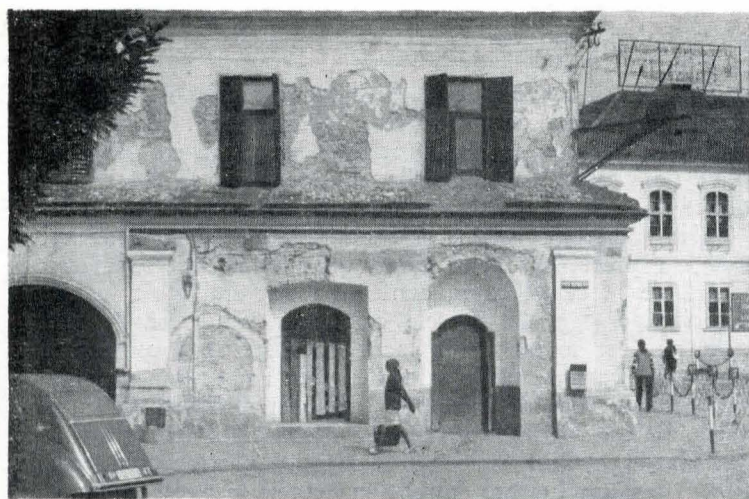
Fig. 7. Sondaje pe fațada sud-vest.
