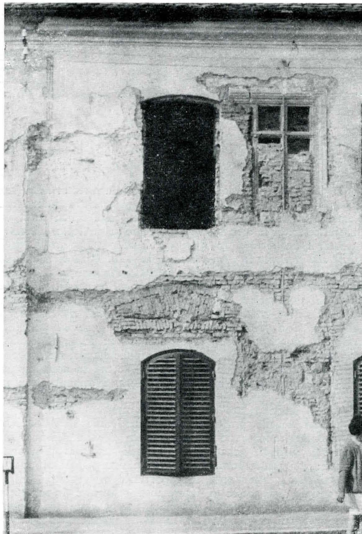
Fig. 5. Sondaje de parament pe fațada sud-est. Resturile unui ancadrament de piatră de la etaj.
