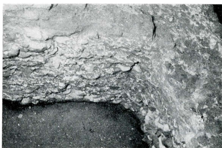
Fig. 9. Fundația absidei sudice și fundația pridvorului lărgit
