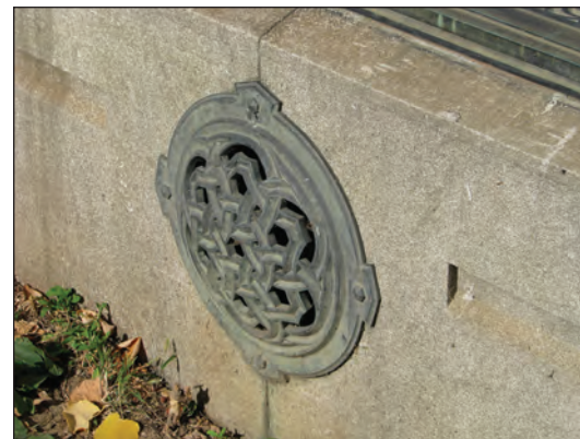
Fig. 3 - Detaliu aerisire cavou fam. Smărăndescu – arh. Paul Smărăndescu 1927/Smarandescu family crypt - ventilation detail – arch. Paul Smarandescu 1927. Foto arh. Andreea Pop
