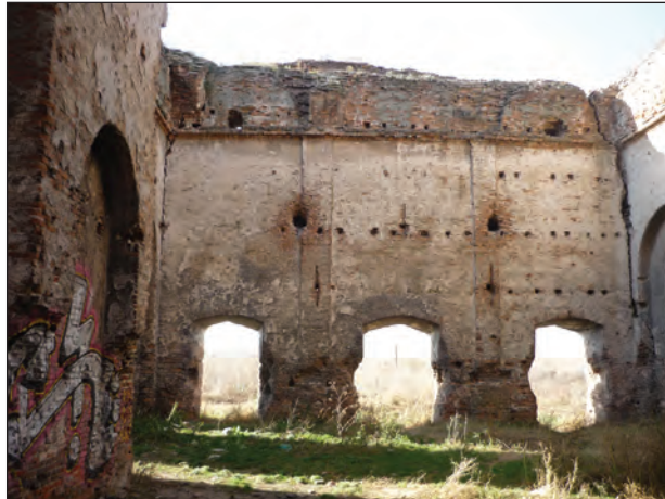
Fig. 12. Ruina bisericii Mănăstirii Giulești: pronaos, vedere interioară. Foto arh. D. D. Ionescu, 2010
