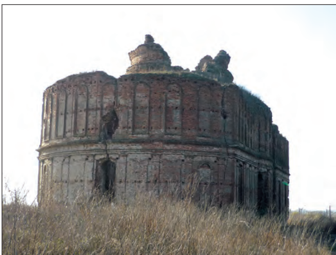
Fig. 14. Ruina bisericii Mănăstirii Giulești: vedere dinspre NE, 2010, foto arh. D. D. Ionescu
