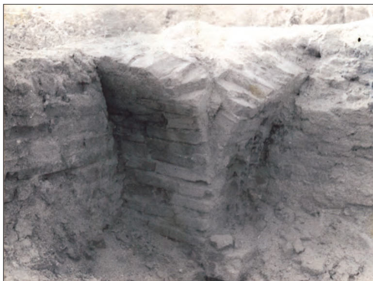
Fig. 13 - Un stâlp despărțindu-se în două bolți tip arcadă/ A column parting in two arcades
