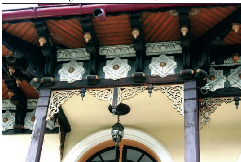
Fig. 11 - Casa Ion Bucșa, Constantin Marmandiu (Vila Livia), înc. sec. XX; detaliu stucatură; renovată în 2007
