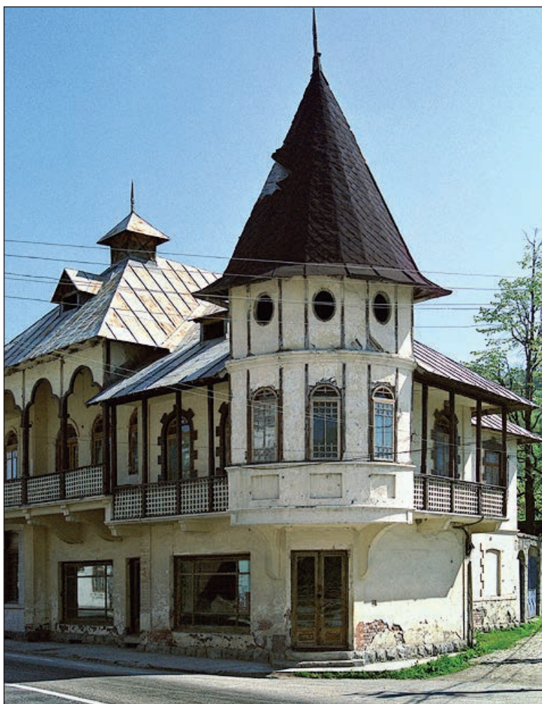
Fig. 16 - Casa Alfil (Ahil) Grigorescu, construită după 1920
