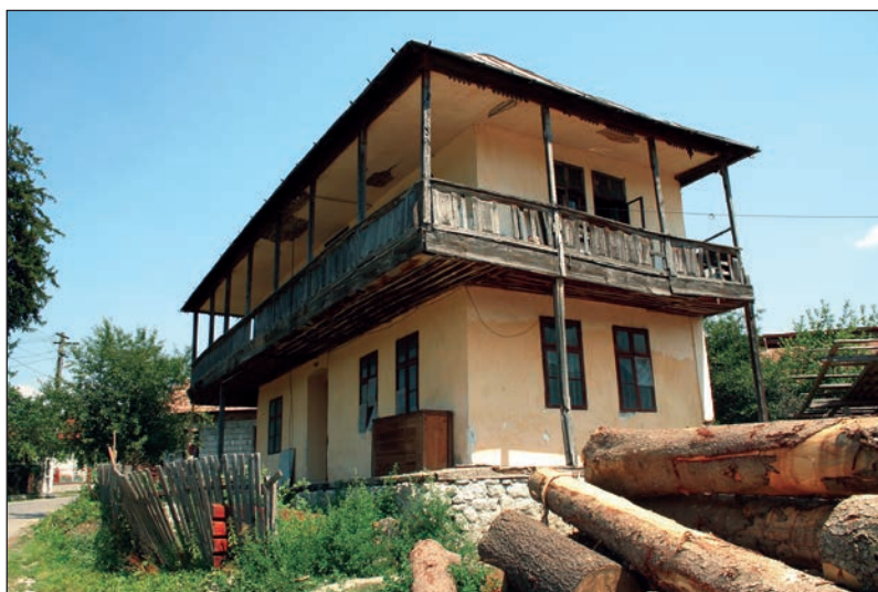
Fig. 3 - Casă cu parter din piatră și etaj din lemn; a avut prăvălie și cârciumă; demolată în 2009
