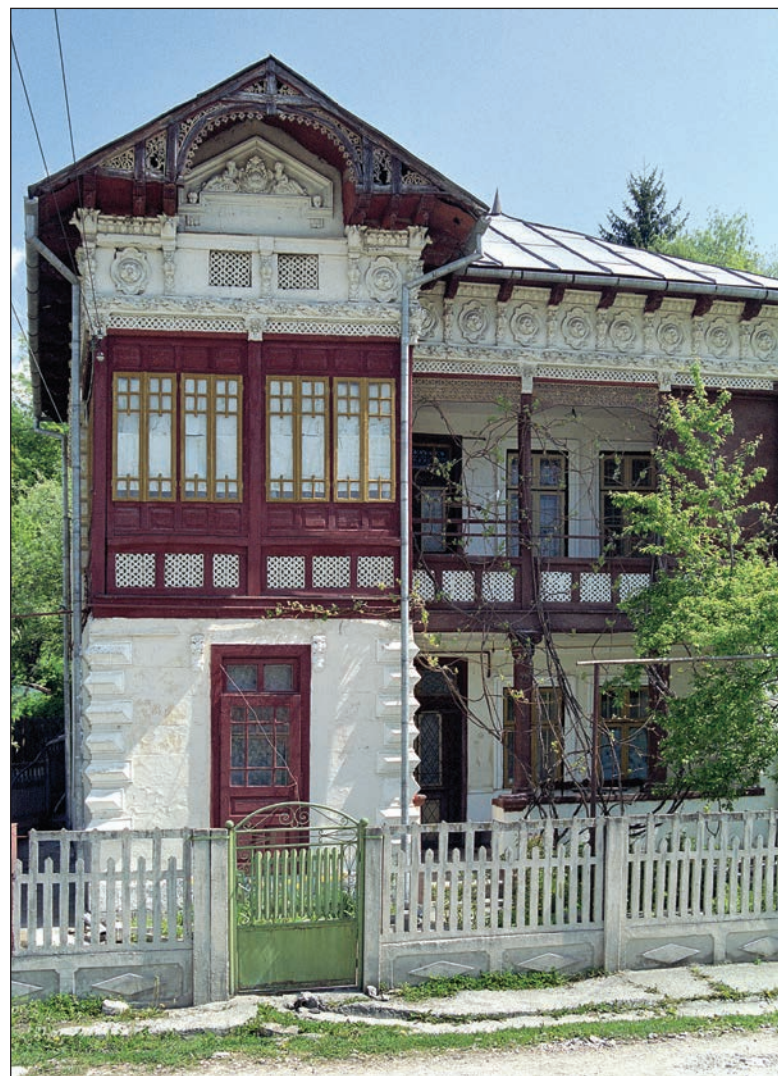
Fig. 12 - Casă cu stucaturi construită la înc. sec. XX, adosată unei case de sec. XIX
