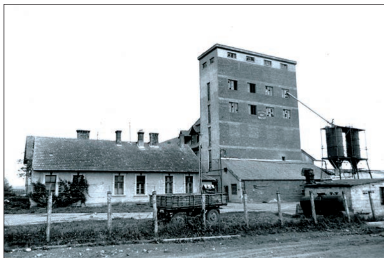
Fig. 3. Moara și uzina electrică
