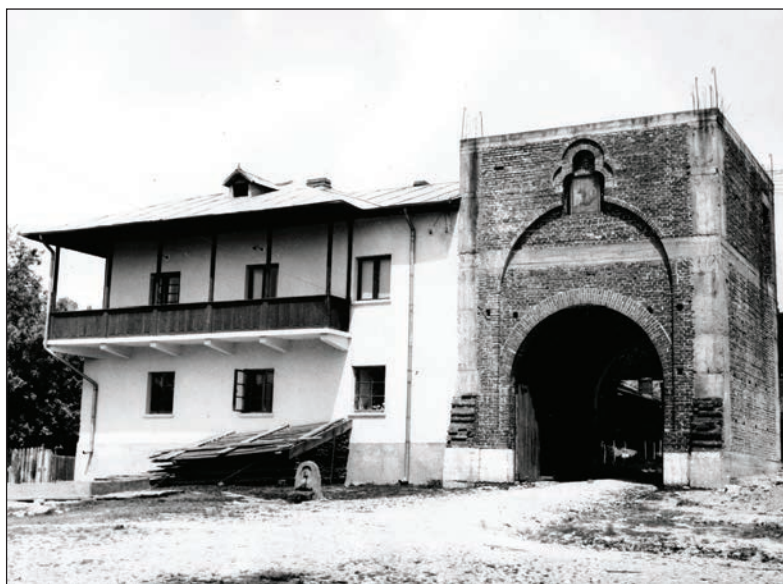
Fig. 9 – Turnul clopotniță și stăreția în reconstrucție, foto D.M.I. cca 1959, fototeca I.N.P.
