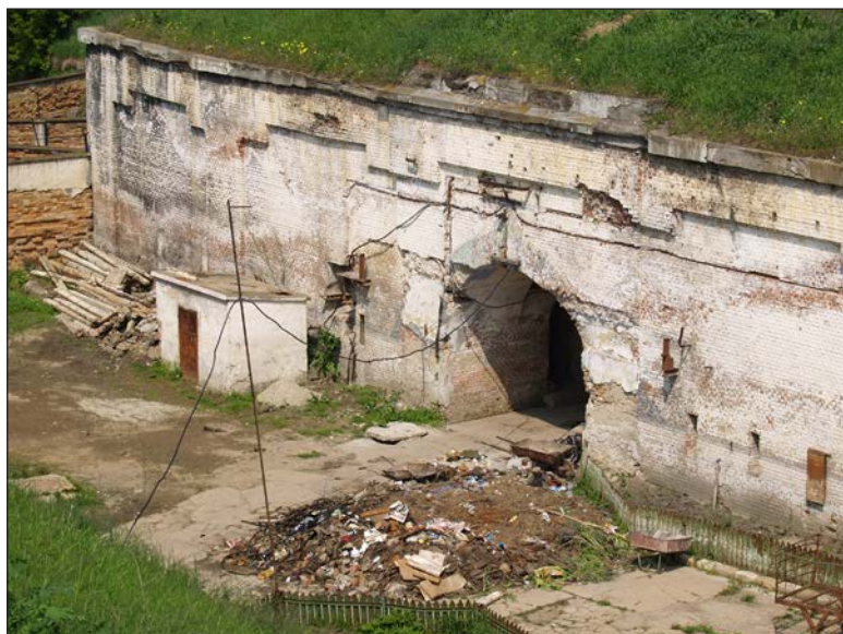
Fig. 34 - Masivul intrării - acces interior - foto arh. Margareta Mihăilescu
