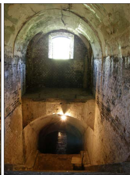
Fig. 31 - Corp B - Reduit - casa scării centrale - foto arhg. Raluca Iosipescu
