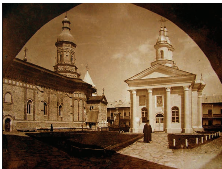
Fig. 12 - Mănăstirea Neamț, sec. XV. Arhitectul Balș a decis ca la restaurarea bisericii lui Ștefan cel Mare să fie eliminate toate elementele de cornișă, schimbarea formei șarpantei bisericii și a șarpantei turnului și revenirea la imaginea de epocă. În incintă s-a decis eliminarea bisericii neoclasece și amenajarea unei capele, în corpul chiliilor, la care fațada a preluat elemente din arhitectura bisericii demolate. (Album Mănăstirea Neamț, cca. 1932).
