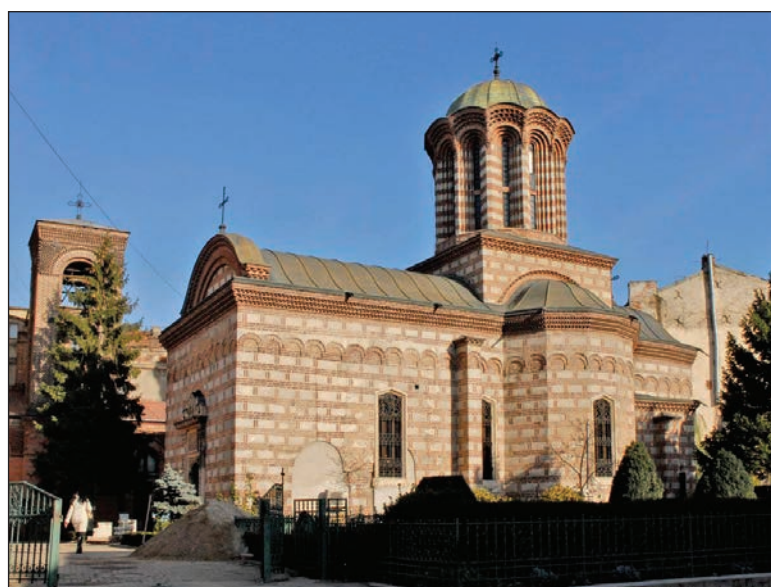
Fig. 11 - Biserica "Buna Vestire" – Curtea Veche, restaurare arh. H Teodoru
