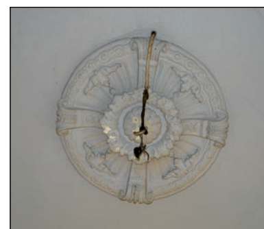
Fig 18 - Imobilul din strada Berzei numărul 89 – (o altă) oglindă de stucatură la etaj – în data de 17 februarie 2011
