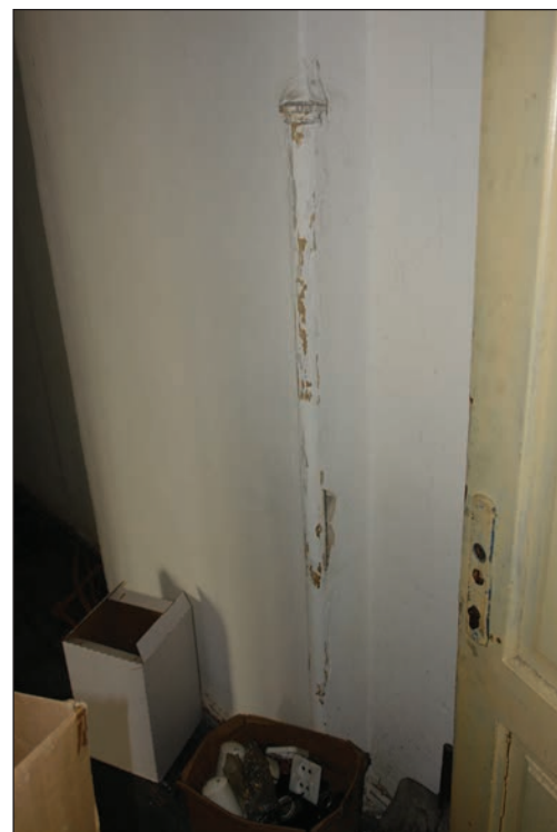
Fig 32 - Imobilul din strada Berzei numărul 81 - corpul principal: protecție pentru muchia zidului la parter - în data de 17 februarie 2011
