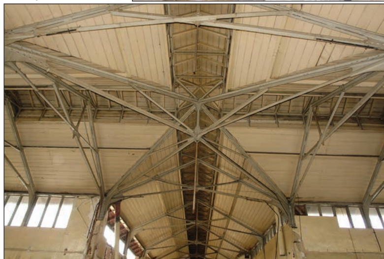
Fig 9 - Hala Matache – detaliul acoperirii din zona centrală – în data de 15 februarie 2011
