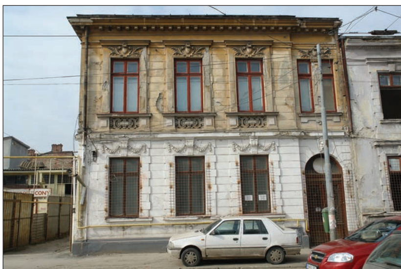
Fig 33 - Imobilul din strada Berzei numărul 81 - corpul principal: elevația spre stradă, de E - în data de 17 februarie 2011
