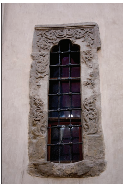
Fig 11. Ancadrament de fereastră. Fațada sudică.
