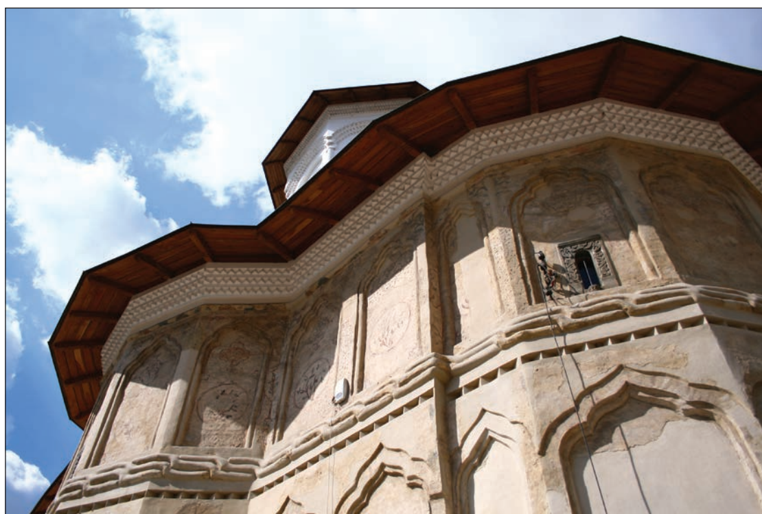
Fig 12. Fațada de sud.
