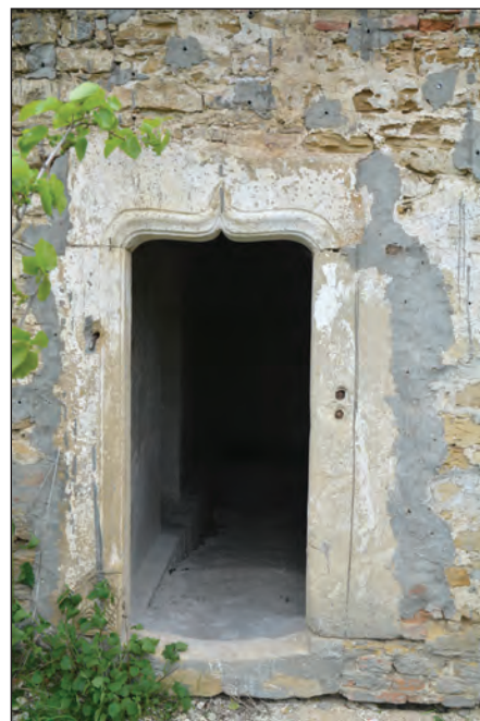
Fig. 27. Golul ușii principale de acces la parter din foisorul de est, încadrat în piatră și închis în acoladă
