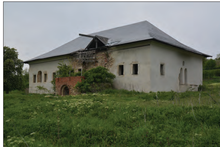
Fig. 25. Conacul - vedere de ansamblu dinspre N-E
