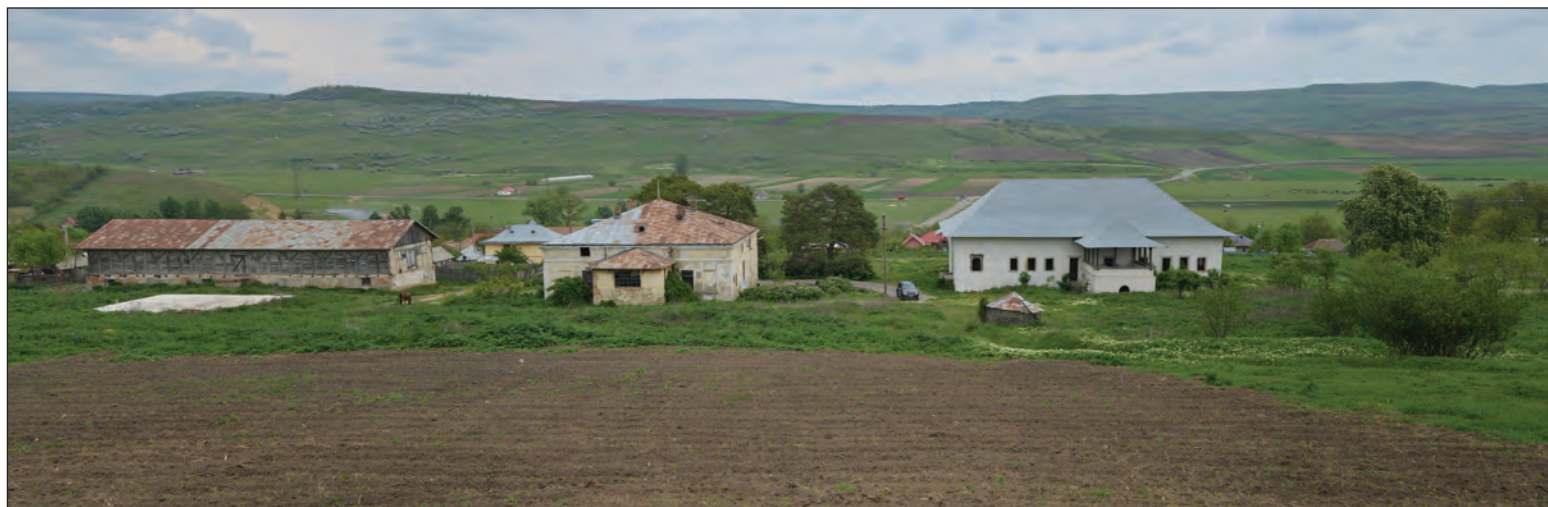
Fig. 21. Vedere de ansamblu asupra conacului și a anexelor (dinspre V)
