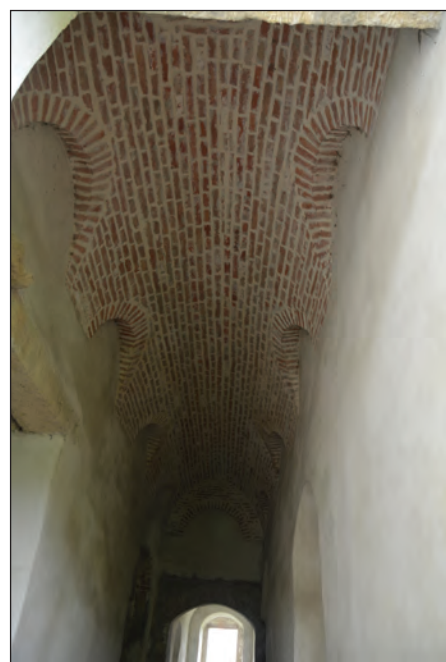
Fig. 31. Coridor - acoperire cu bolți în leagăn
