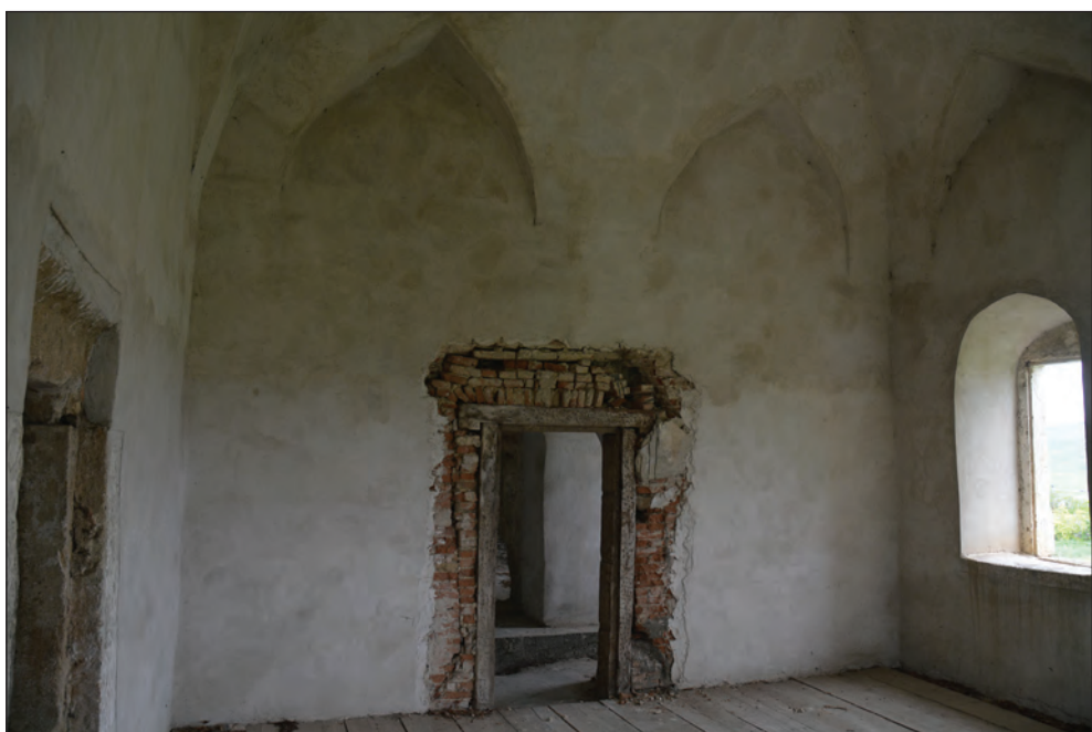
Fig. 30. Interior încăpere - acoperire cu bolți cu muchii ieșite, străpunse de lunete
