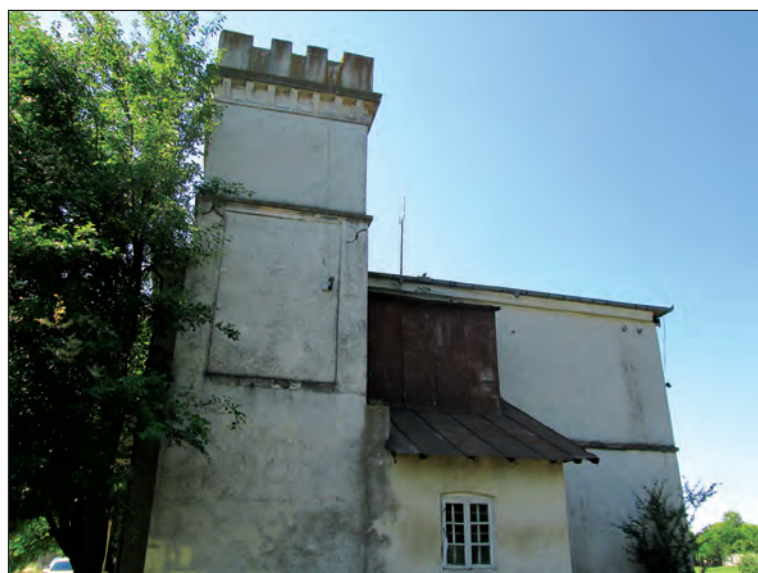
Fig. 11. Turnul de nord, vedere laterală
