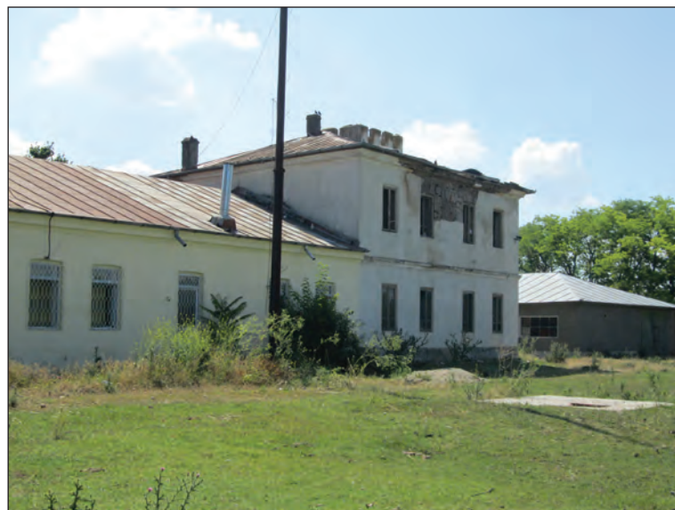
Fig. 13. Corpul lateral de sud, vedere din spate
