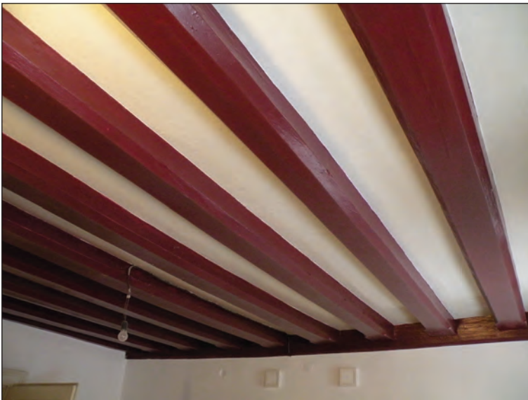
Fig. 7. Plafonul cu grinzi aparente din încăperea din stânga a parterului
