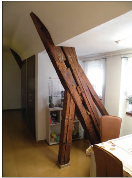
Fig. 15. Piesă de șarpantă în mansardă
