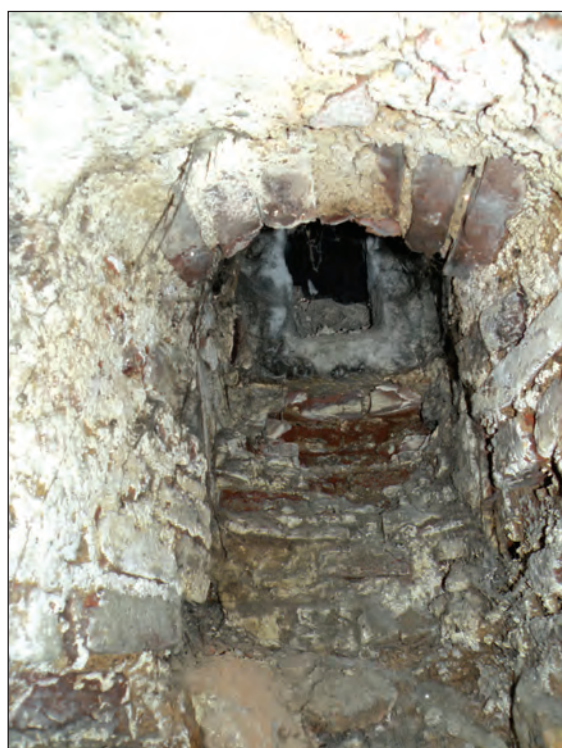
Fig. 6. Gură de aerisire în compartimentul din dreapta al pivniței
