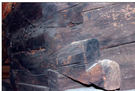
Fig. 12. Tehnica de îmbinare, coada de rândunică
