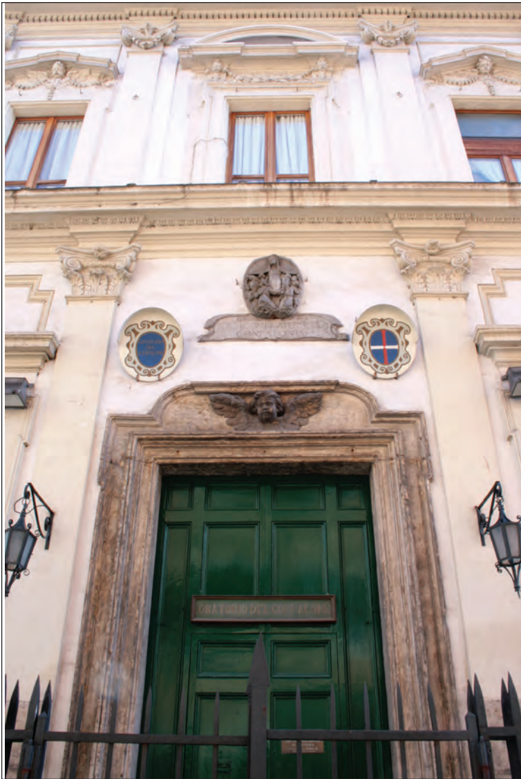
Fig. 1. Oratorio del Gonfalone. Fațada principală, detaliu.
