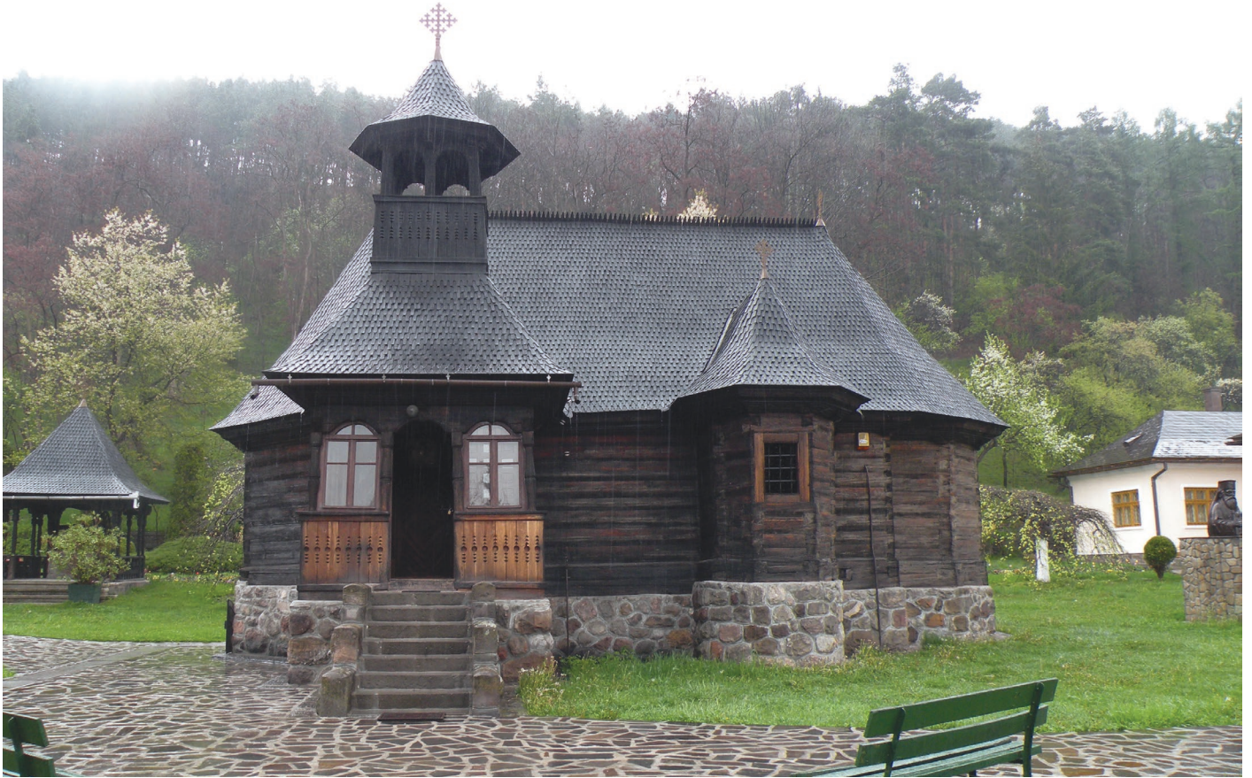
Fig. 1 Biserica de lemn a mănăstirii Sf. Ilie Proorocul din Toplița, văzută dinspre sud (Foto: Aurelian Stroe, mai 2019).
