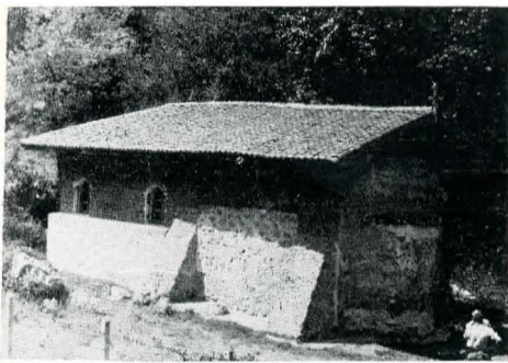
Fig. 6. Biserica Sf. Dumitru de lângă satul Baboșevo. Construită în secolul XV, prezintă un plan dreptunghiular, compartimentat în pronaos și naos, cu o mică absidă pe latura estică. Recenta consolidare a recurs la o soluție foarte incisivă, monumentul fiind îmbrăcat într-o zidărie masivă prevăzută cu contraforturi, astfel că silueta originală a fost integral modificată.
